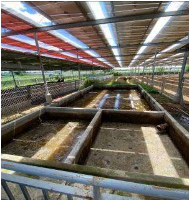
Hình ảnh các ngăn xử lý nước thải tại bể số 1
